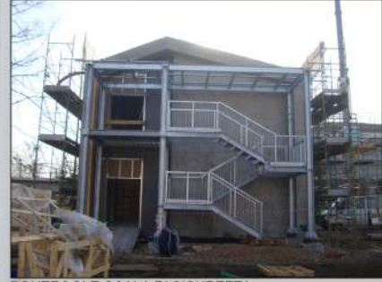
PONTEGGI E SCALA DI SICUREZZA
