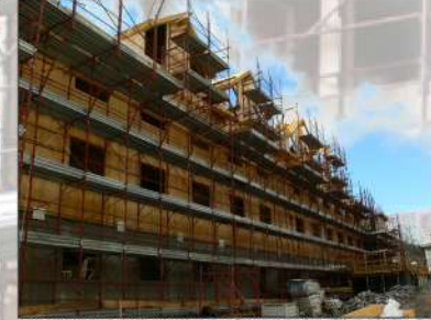
Vista esterna dell'impalcatura e delle elevazioni in xlam
