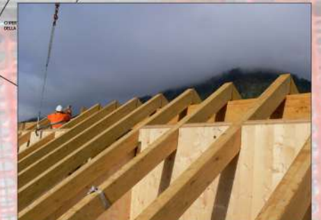
Posa travi di copertura
