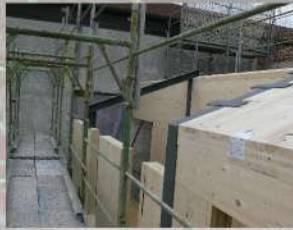
POSA STRUTTURA IN XLAM
