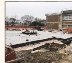
Realizzazione di solaio controterra - 2° lotto
