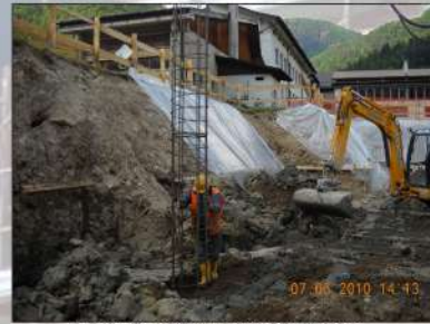
Posa dell'armatura dei pali di fondazione
