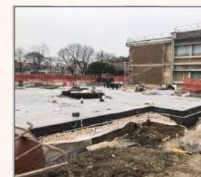
Realizzazione di solaio controterra - 2° lotto
