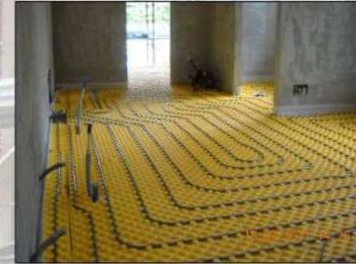
Posa impianto radiante a pavimento
