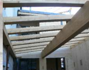
POSA TRAVI DI COPERTURA
