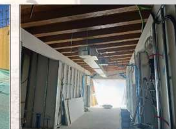
Posa impianto di VMC a soffitto - 3° lotto
