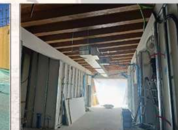
Posa impianto di VMC a soffitto - 3° lotto
