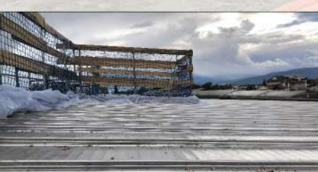
Posa parapetto durante i lavori in copertura - 3° lotto
