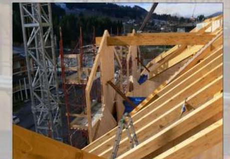
Posa travi di copertura e pareti in xlam
