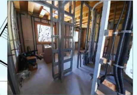
Posa delle partizioni interne e corrugati per passaggio impianti
